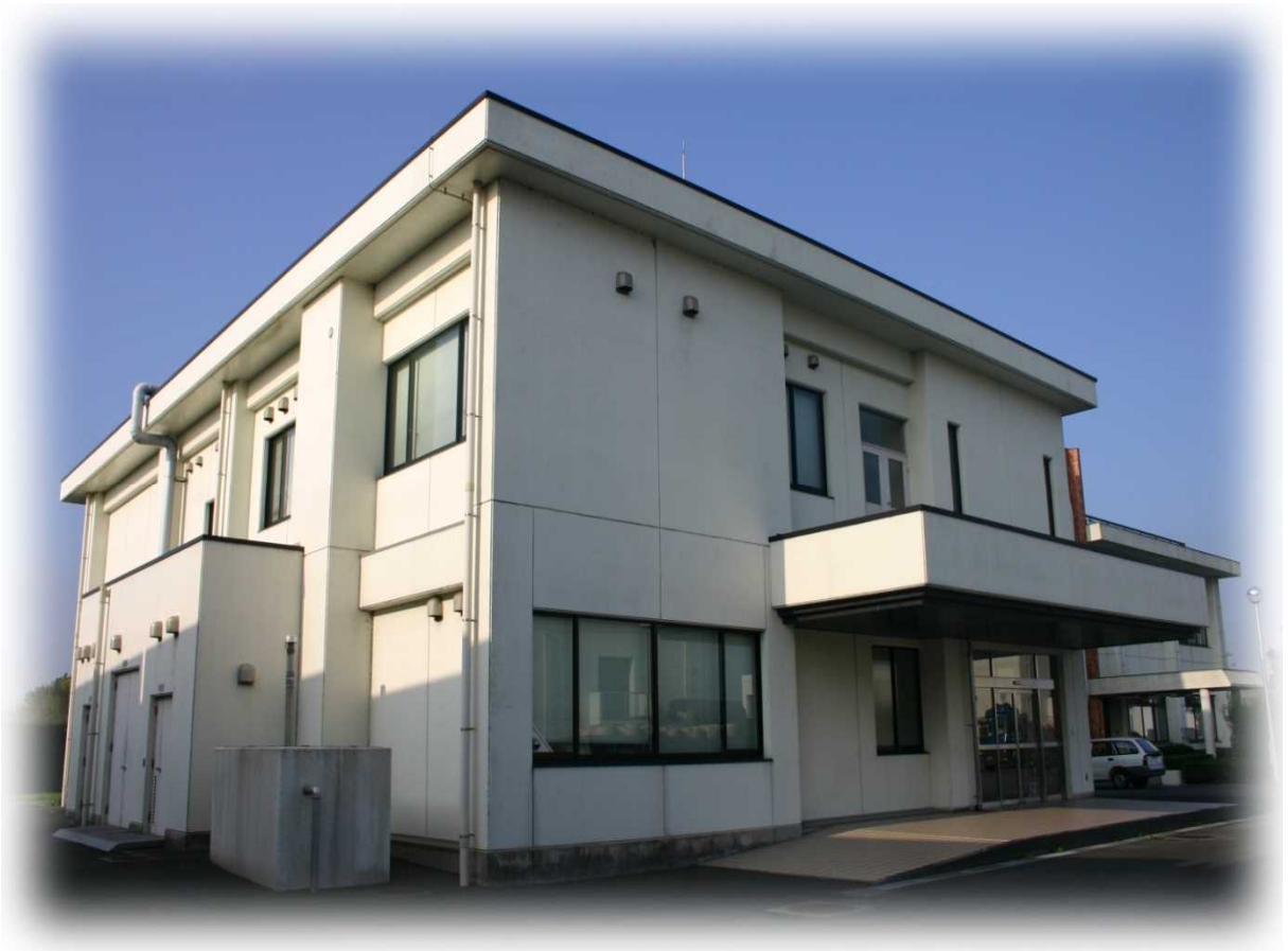
水質センター（十日市場浄水場内に設置）
